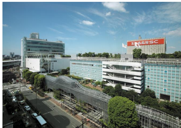
玉川高島屋外観
